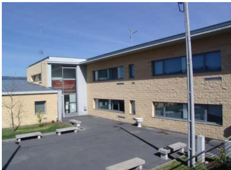
Fig.2. Edifício da Delegação de Ponte da Barca
